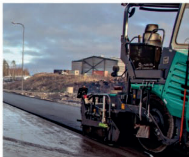
Laura Mikkola sanoo, että kierrätysbitumista valmistettu asfaltti on sitkoisena jopa helpommin jyrättävää kuin puhtaasta bitumista valmistettu massa.
